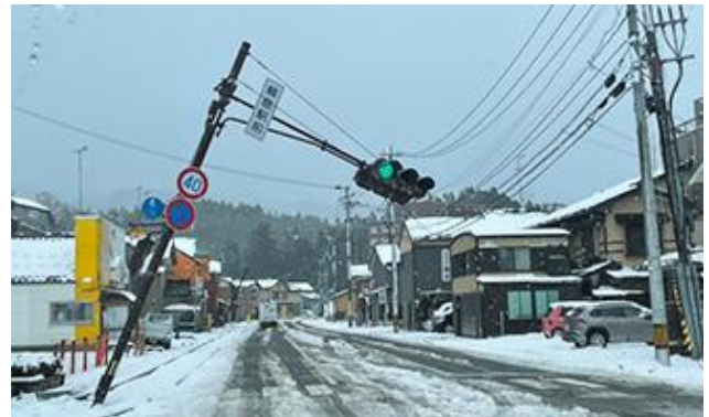
輪島駅前の傾いた信号機
